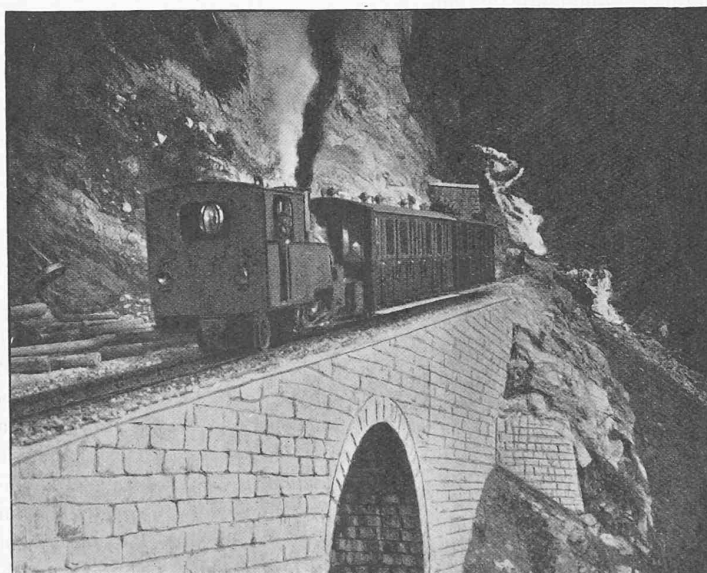
Fig. 3. — Tête aval du tunnel du Greppon.
