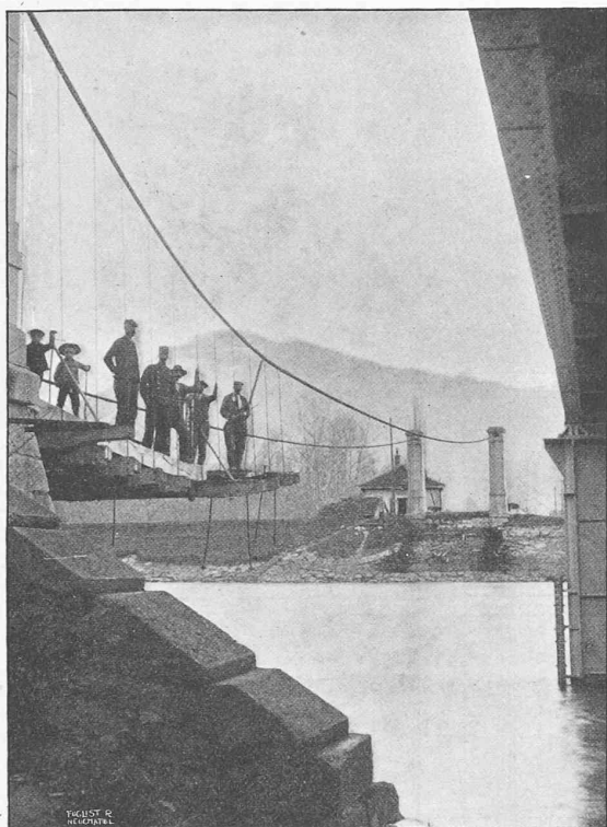
Fig. 2. — Démolition de l'ancien pont suspendu.
