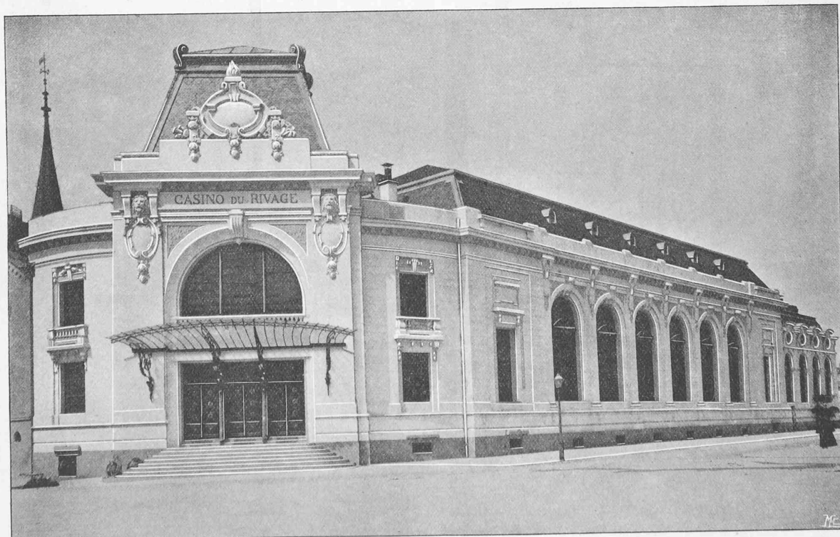
Vue d'ensemble. — Architecte : M. Ch. Coigny, à Vevey.
