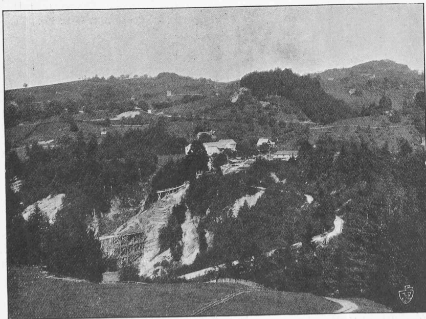
Fig. 10. — Le nouveau pont en construction et l'ancien pont.
