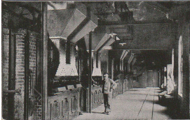
Installation d'alimentation automatique de générateurs
