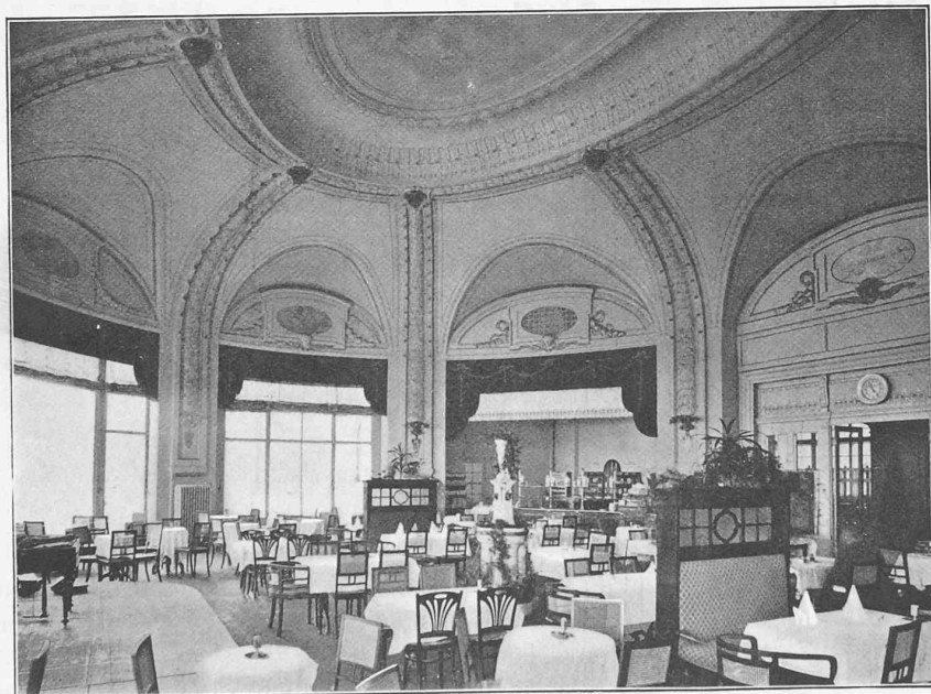
Vue du restaurant.
