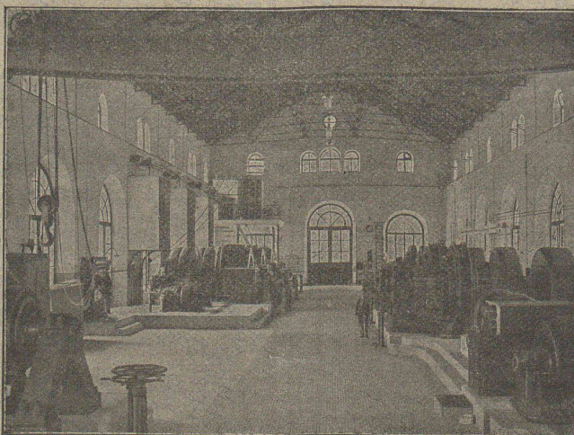
Usine d'électrochimie de Martigny. — Local des turlines.
