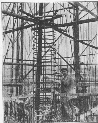
Fig. 10. — Ferrailage d'une colonne frettée.
