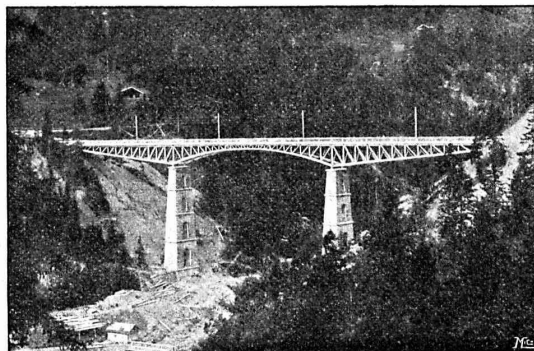
PONT SUR LA GRYPONNE LIGNE BEX-GRYON-VILLARS
