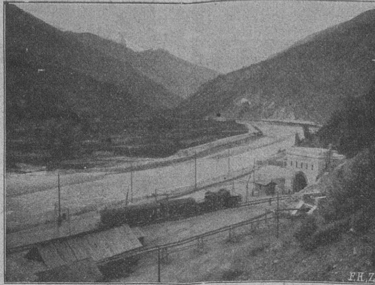
Portail Nord du Tunnel du Simplon.
