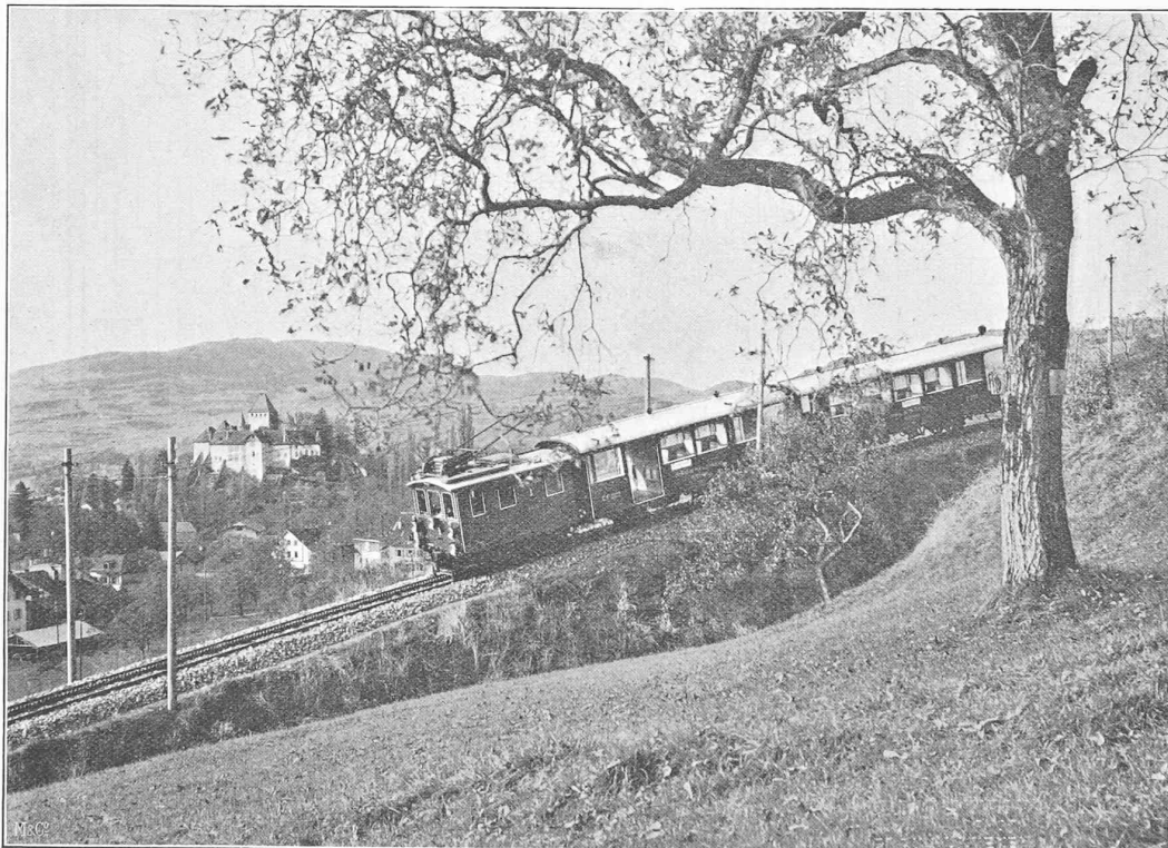
Fig. 15. — Vue d'un train sur rampe de 200 ‰.
