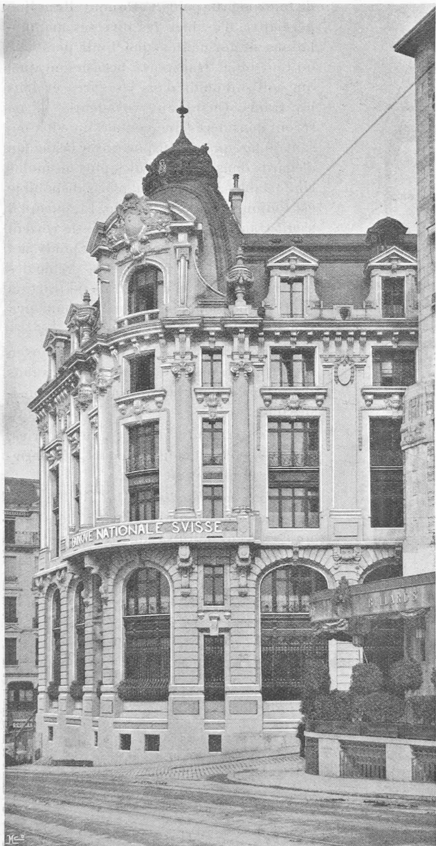
Le bâtiment de la Banque Nationale, à Lausanne. Architectes : MM. Verrey et Heydel.
