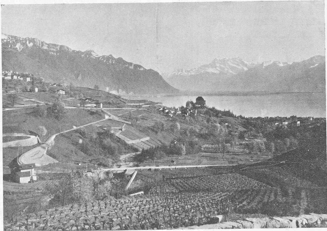
Fig 1. — Pont sur la Baye de Clarens et développement de la ligne aux Râpes.
