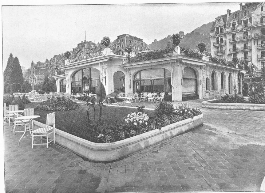
Vue de la Terrasse.
