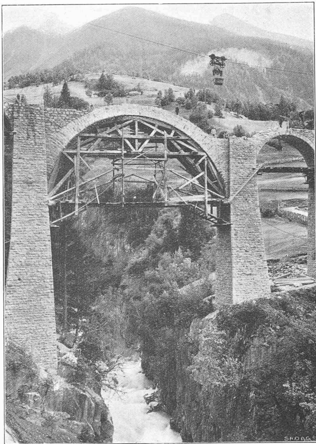
Fig. 14. — Le viaduc de Grenchiols.
