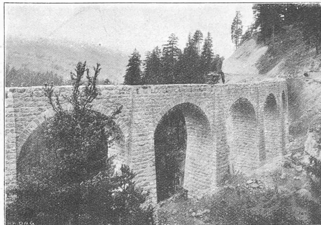
Fig. 15. — Le viaduc de Laxgraben.
