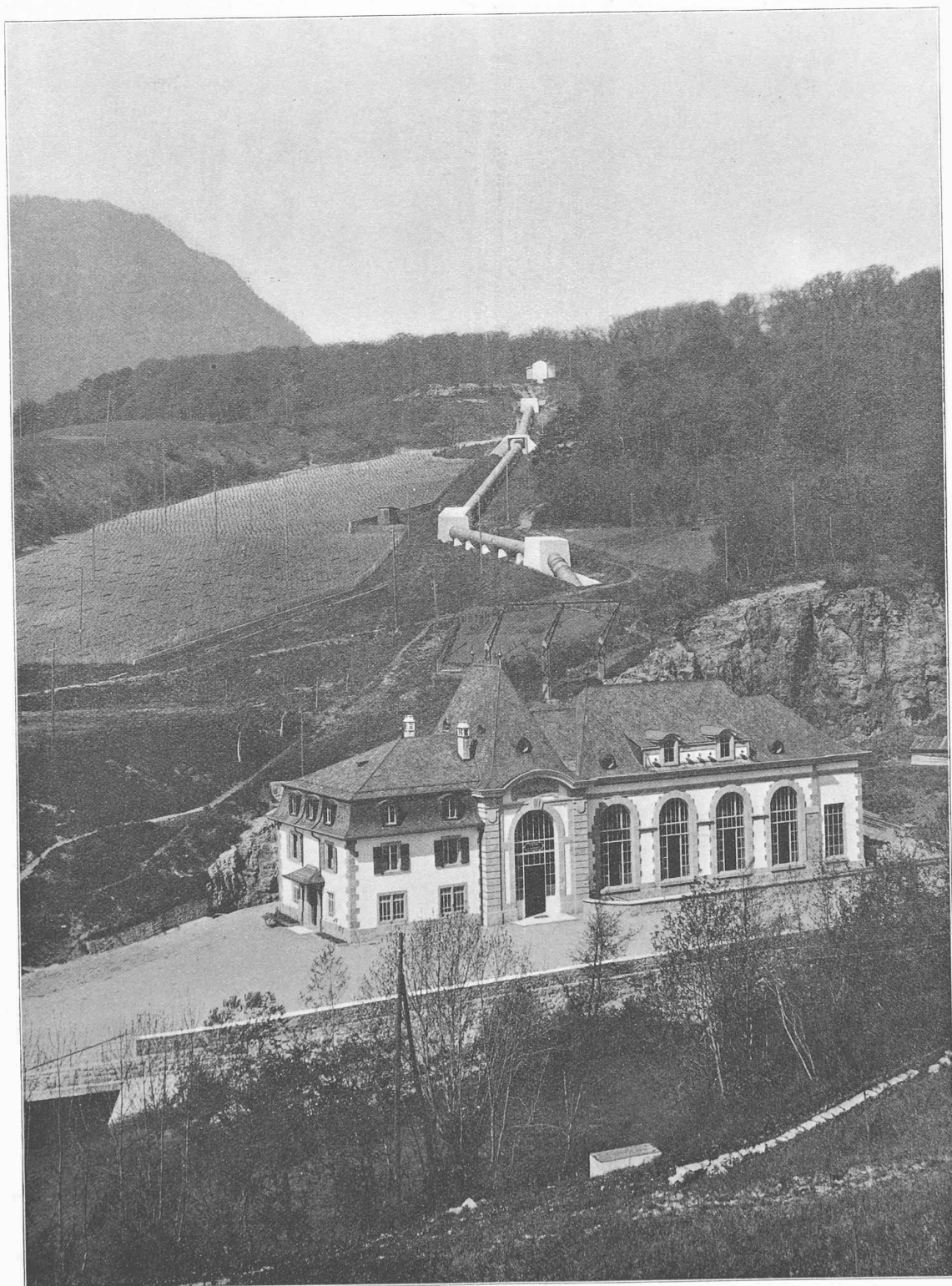
VUE DE LA NOUVELLE USINE DES PRÈS DU CHANET, PRÈS BOUDRY, APPARTENANT A LA VILLE DE NEUCHÂTEL
