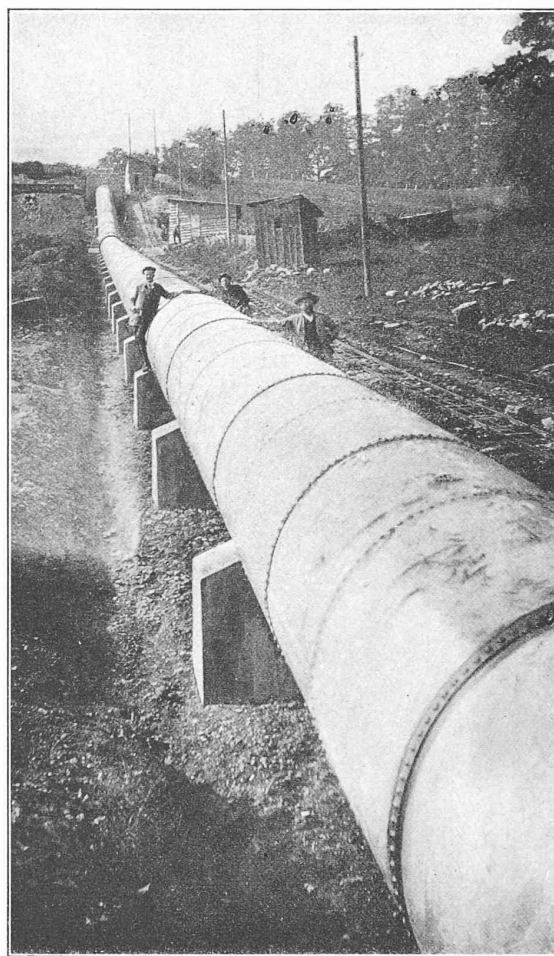
Fig. 15. — Vue de la conduite forcée.
