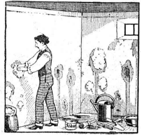
Tout emplacement situé sous l'eau est rendu imperméable par l'emploi du sika rapide.
