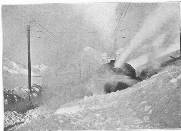
Fig. 62. — Chasse-neige en action sur la ligne de la Bernina.
