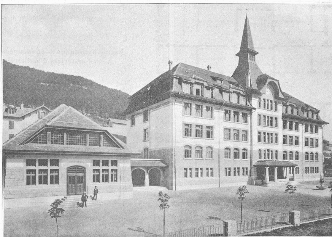
Face angle sud-ouest
