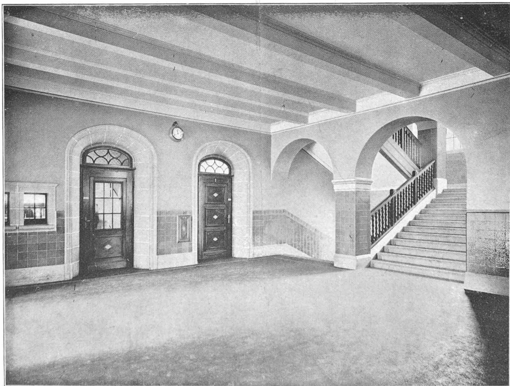
COLLÈGE DE MONTRIOND, A LAUSANNE Architecte : M. G. Hämmerli, à Lausanne.
