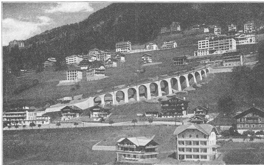
Fig. 1. — Vue du mur évidé.
