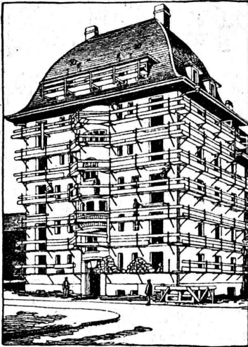
Vue d'un bâtiment muni d'un échafaudage «HERKULES»
