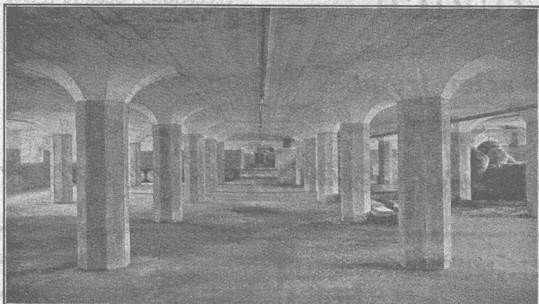
Plancher sans nervures, système Maillart. — Sous-sol d'entrepôt.
