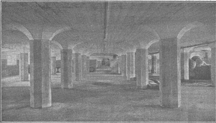
Plancher sans nervures, système Maillart. — Sous-sol d'entrepôt.
