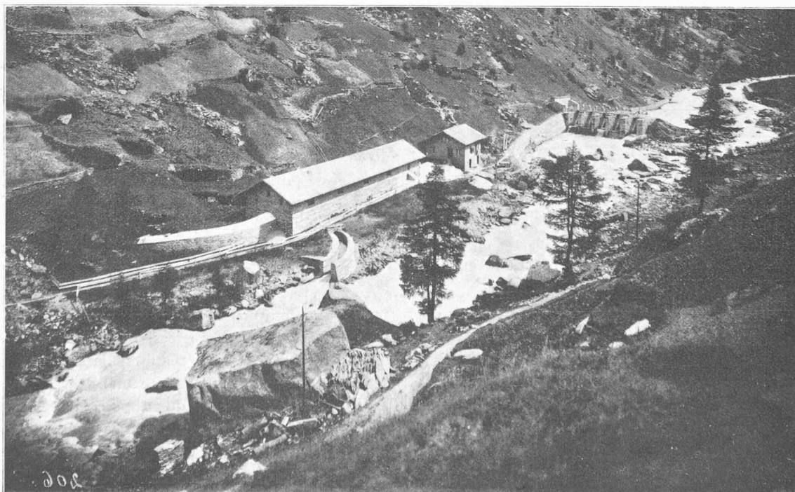
Fig. 12. — Vue extérieure du dessableur de l'usine de l'Ackersand, à Saas-Balen.
