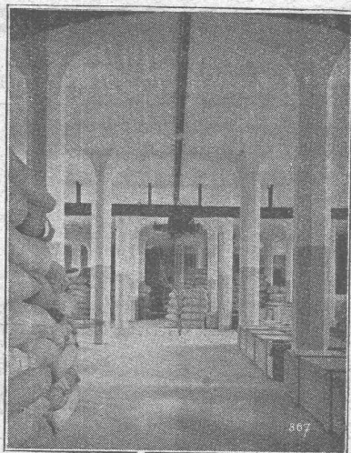
Rez-de-chaussée d'un Entrepôt, à Zurich
