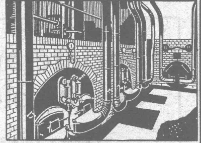
Installation de soufflerie sous grille « Fohn » pour combustibles pauvres
