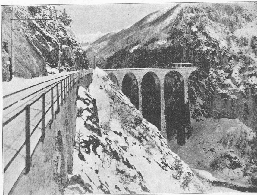
Fig. 1. — Viaduc de la Landwasser, près de Filisur.
