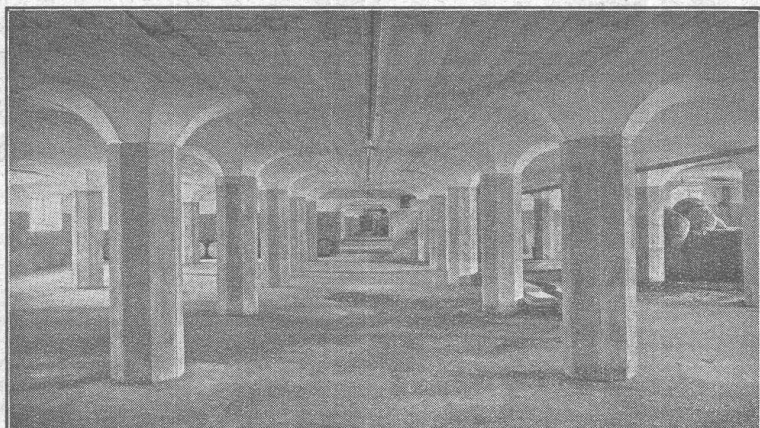
Plancher sans nervures, système Maillart. — Sous-sol d'entrepôt.
