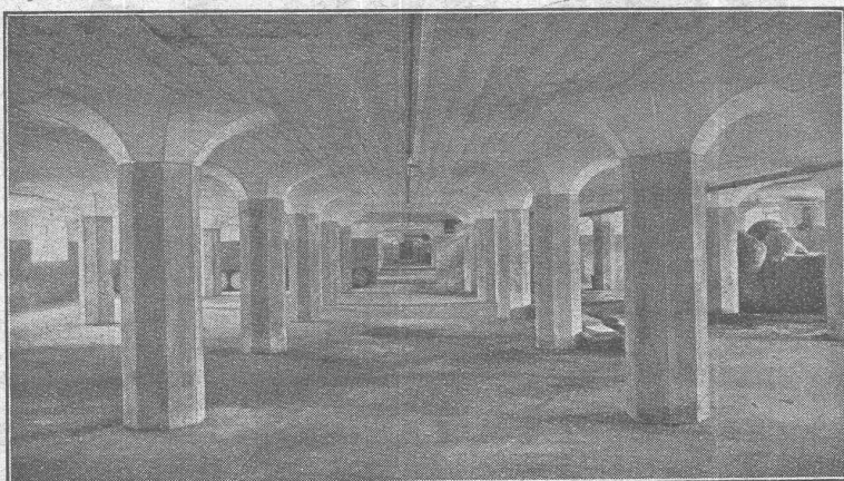
Plancher sans nervures, système Maillart. — Sous-sol d'entrepôt.
