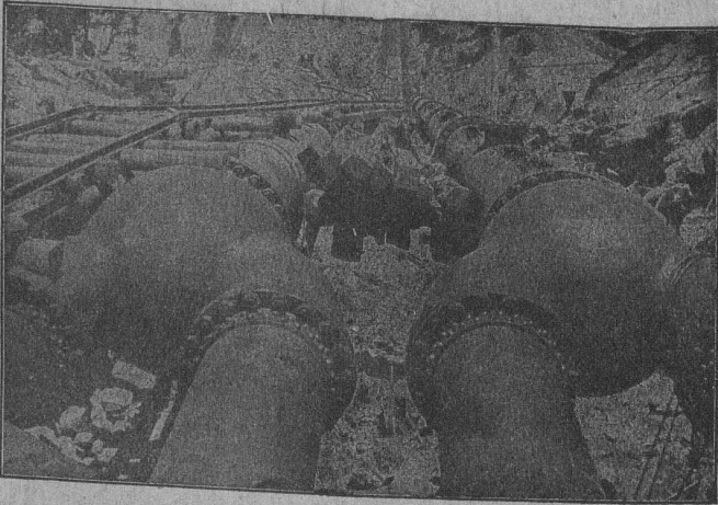
Conduite de turbine de Big Creek (Californie). Transition de deux conduites de tubes sur quatre au moyen de tubes Y fonte acier. Poids total de la fourniture : 8,700 tonnes.
