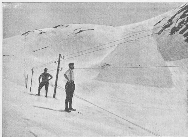
Fig. 1. — Versant ouest du col des Andérets. Traversée du plateau d'Isenau. Les 3 fils à haute tension et les 2 fils du téléphone de service. Hauteur moyenne de la neige : 4,50 m.
