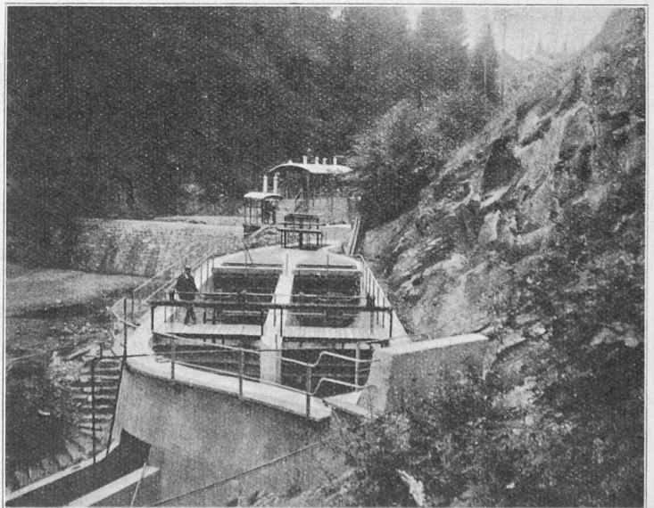
Fig. 31. — Dessableur du Pont-du-Pas, vue de l'aval vers l'amont.
