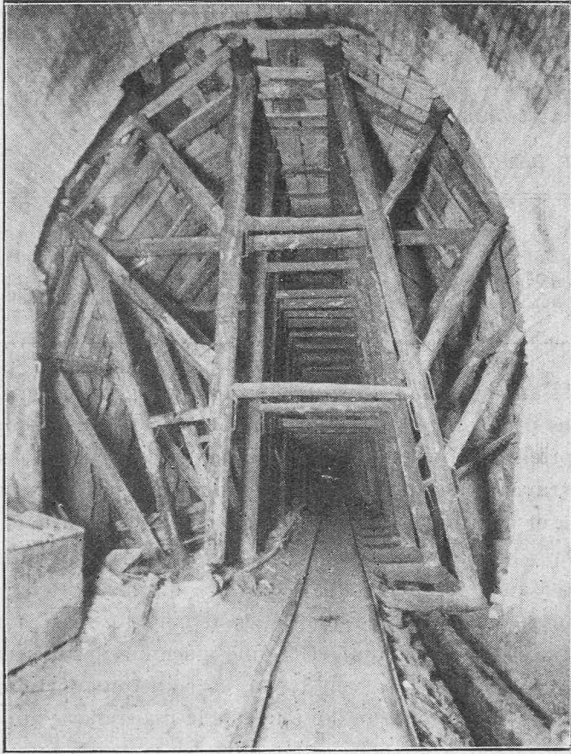
Fig. 1. Pose de supports allongés dans la roche saine.
