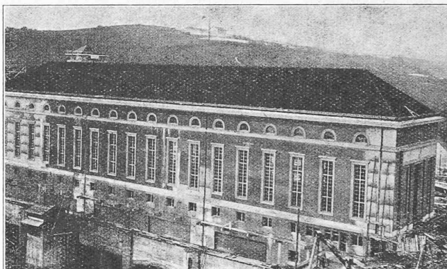
Fig. 2. — Bâtiment des turbines. Vue prise sur la rive gauche, en aval.
