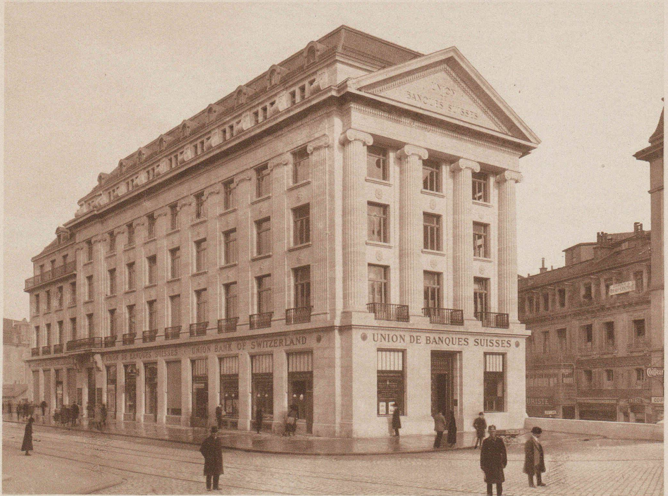
Hôtel de l'Union de Banques Suisses, à Lausanne.
