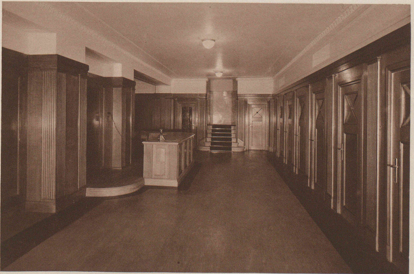
Cabines à disposition des locataires de coffres.
