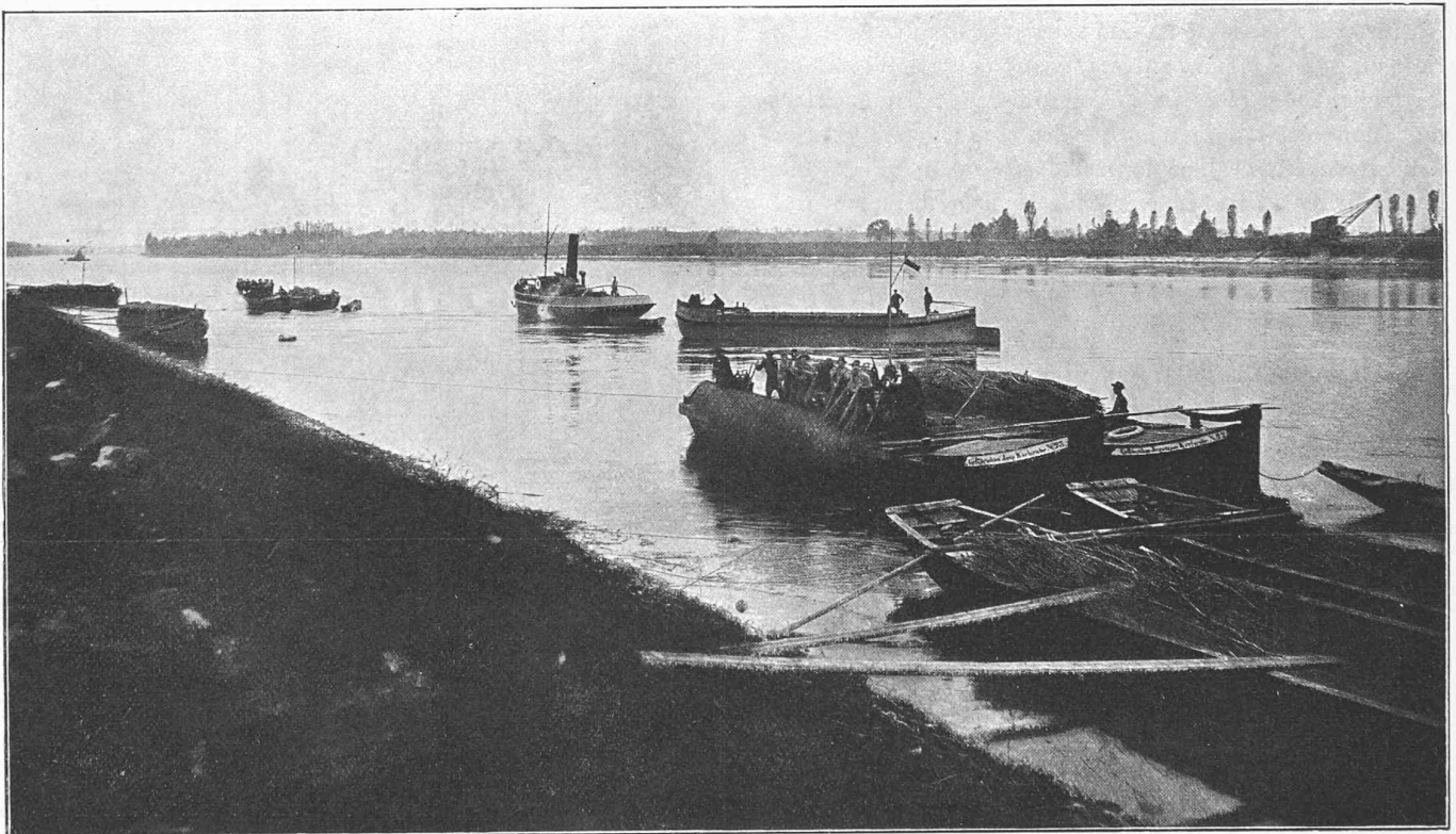
Fig. 2. — Chantier aux environs de Maxau.
