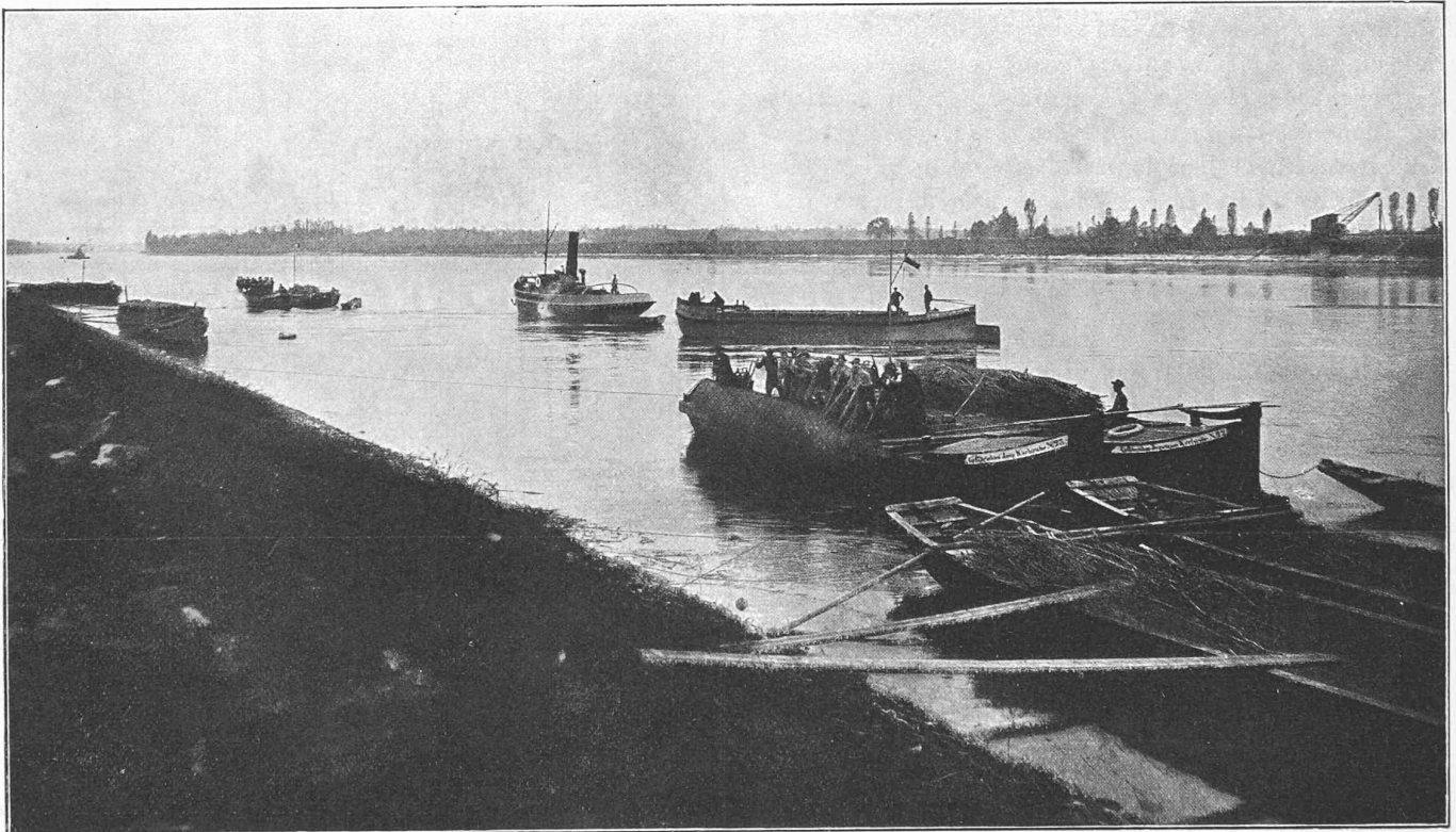
Fig. 2. — Chantier aux environs de Maxau.
