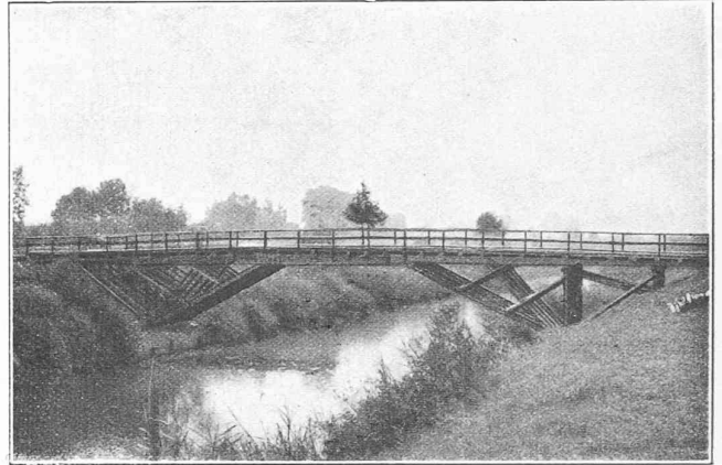
Fig. 8. — Vue du pont à arbalétriers achevé.
