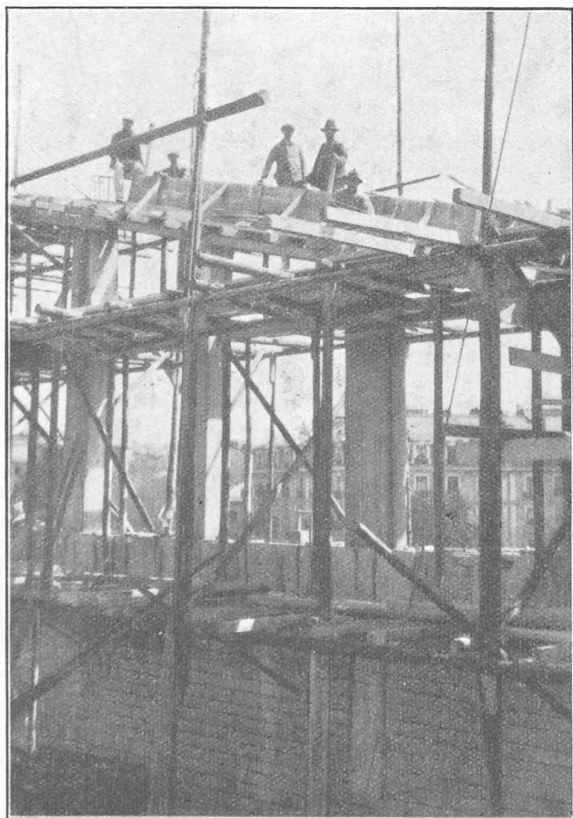
Fig. 8. — Coffrage d'un pignon.
