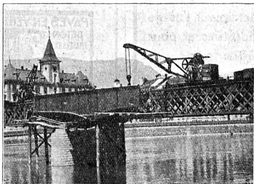
Grue pivotante, sur truck, à volée réglable, force 15 tonnes, utilisée à la réfection d'un pont.
