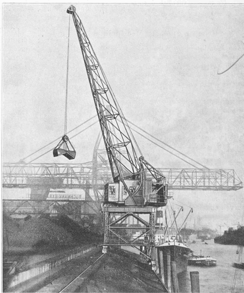
Fig. 3. — Grue de quai, à volée inclinable, dans sa position de portée minimum : 8 m.
