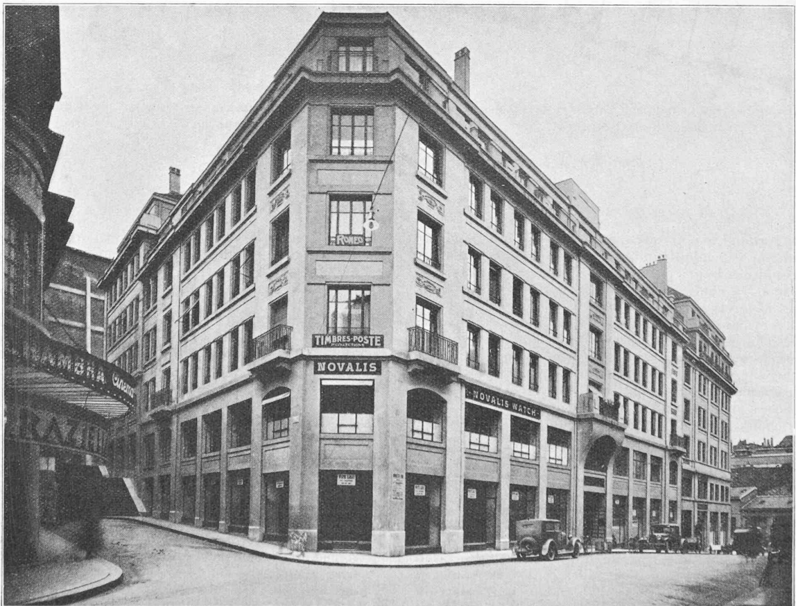
Bâtiment de la Société immobilière « La Citadine », angle rues de la Rôtisserie et de la Pélisserie.
