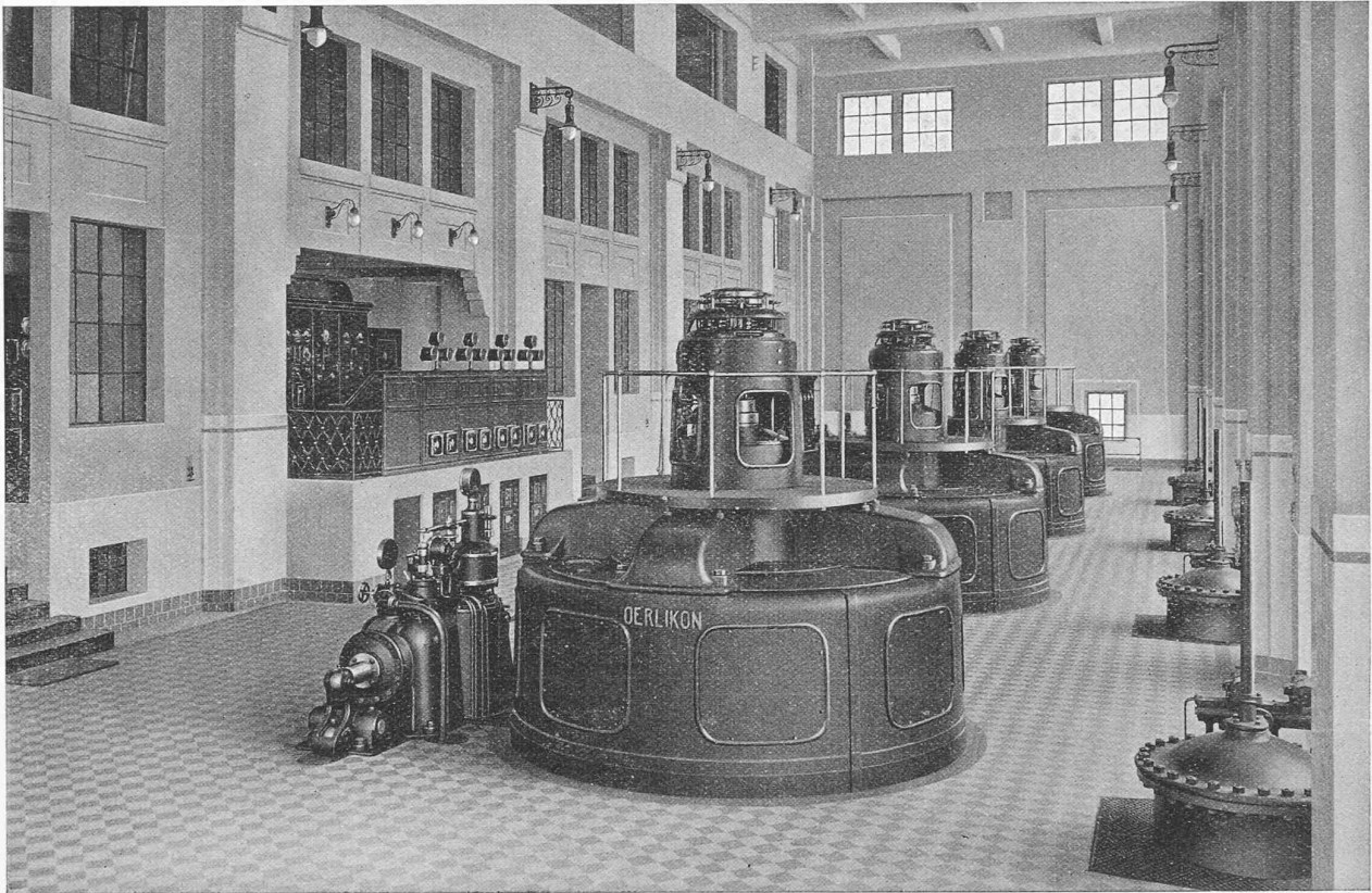
Fig. 17a. — Salle des alternateurs de l'usine de Broc. (Vue du tableau).
