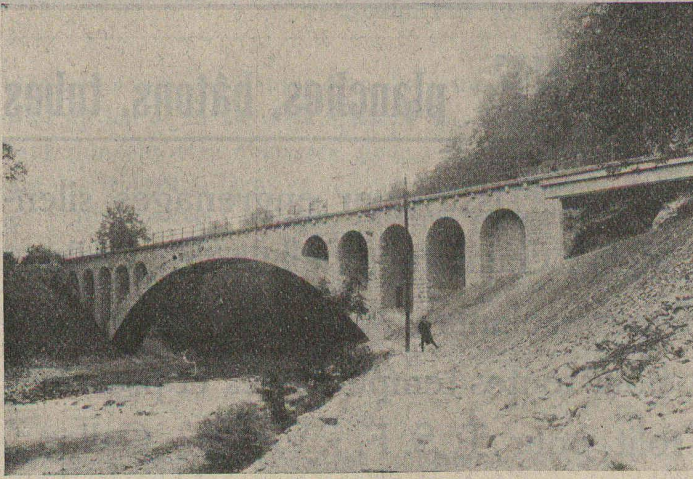
Pont amont C. F. F. du „Kessloch“.
