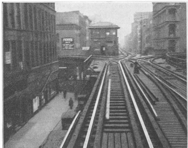
Fig. 4. — Superstructure de la Chicago Rapid Transit Co.
