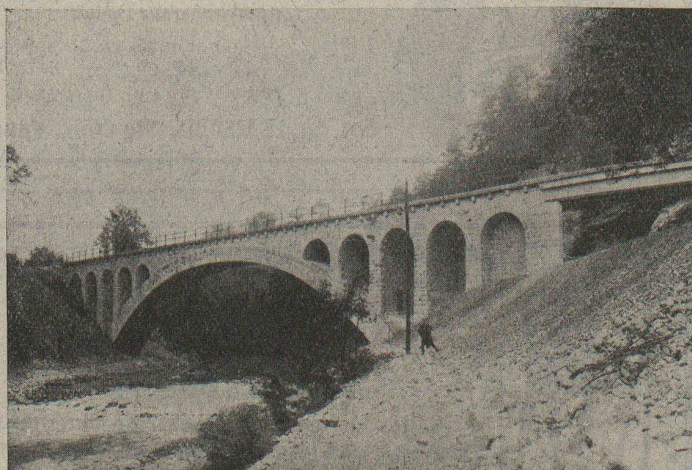
Pont amont C. F. F. du „Kessiloch”.
