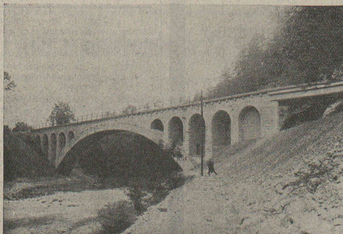
Pont amont C. F. F. du „Kessiloch“.
