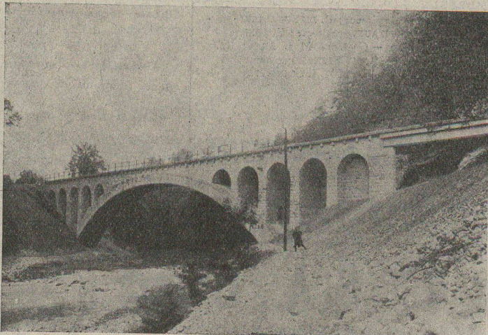
Pont amont C. F. F. du „Kessiloch“.
