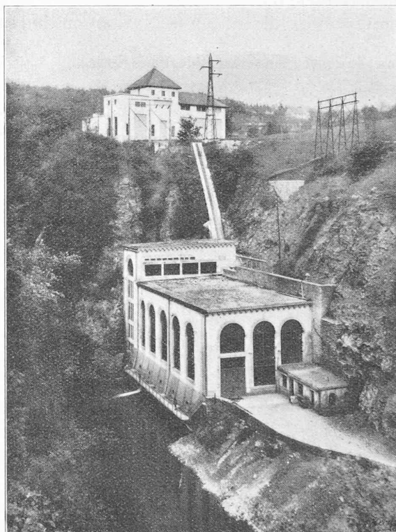
Fig. 5. — Usine et Poste de Montcherand. Côté arrivée de la ligne à 120 kV.
